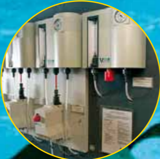
Automatische Chlorgas-Dosierregler
