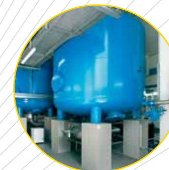
Schnellfilteranlage
