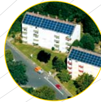
... auf der Immobilie einer Wohnungsbaugesellschaft
