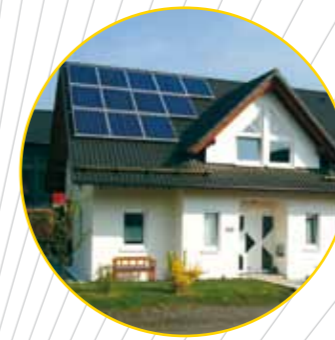
Vierfältige Möglichkeiten: Photovoltaikanlage auf einem Einfamilienhaus
