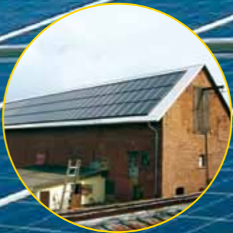
Dachsanierung eines Bauernhofes im Siegerland
